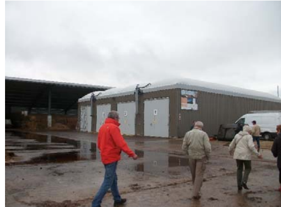
les 4 digesteurs accolés
